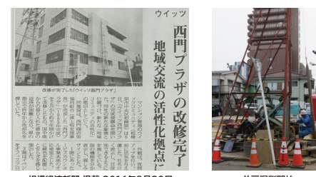
ウイツ 西門プラザの改修完了 地域交流の活性化拠点
