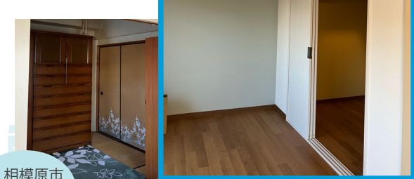
相模原市 I様邸 間仕切撤去で押入れをウォークインクローゼットに
