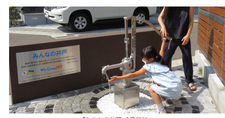
「みんなの井戸」2号機竣工
